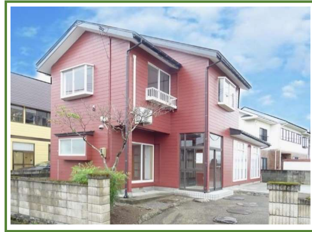
風除室 & 玄関 ( 駐車場 1 )
