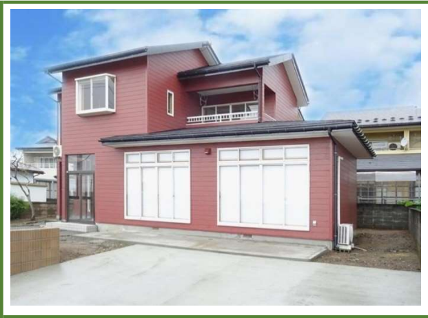
住宅前面(外壁塗装済み)&駐車場2
